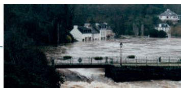
Crue de décembre 2000
